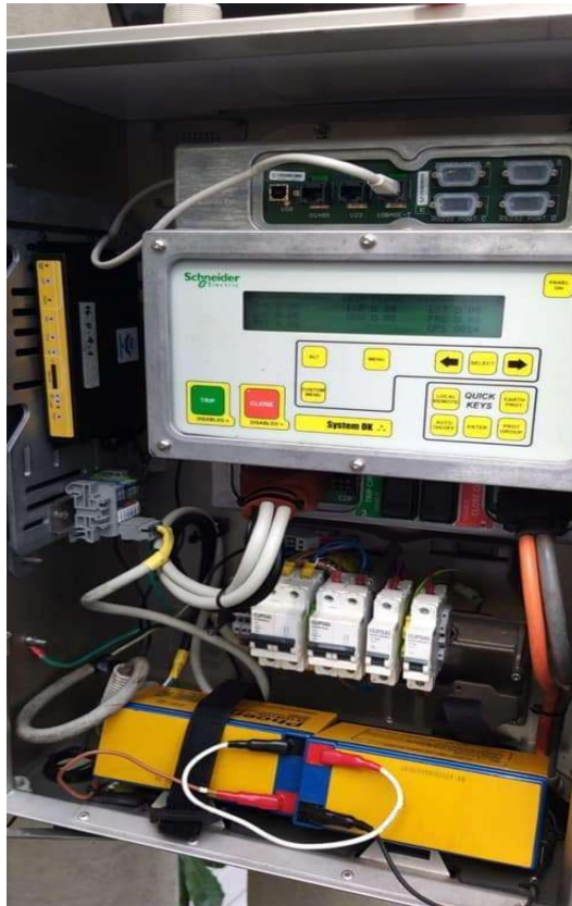
Lắp đặt, kết nối Modem F3425 với máy cắt
